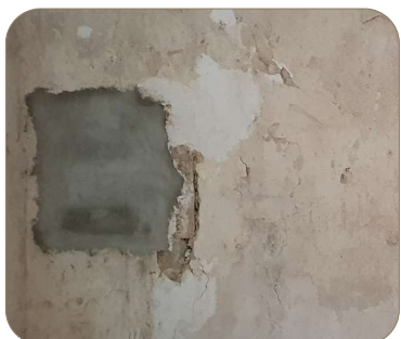
⑪ Reprise de mur au ciment
