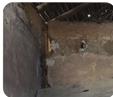
⑭ Mur séparé de la façade
