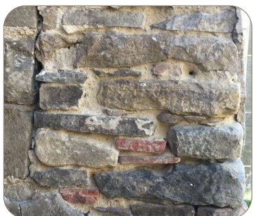
⑪ Contrefort en maçonnerie pierre et brique
