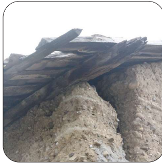
Fuites de toiture - Ravine - Infiltrations d'eau
