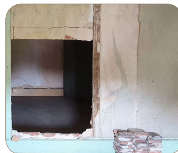
⑨ Ossature bois, briques, plâtre et papier peint
