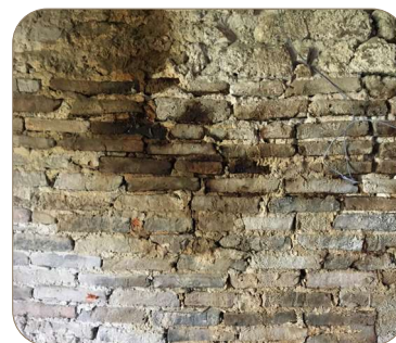
⑨ Reprise de mur en briques
