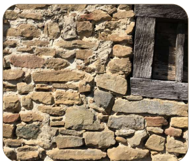
⑥ Maçonnerie pierre et cadre fenêtre bois
