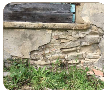
④ Remplissage mixte pierre et brique
