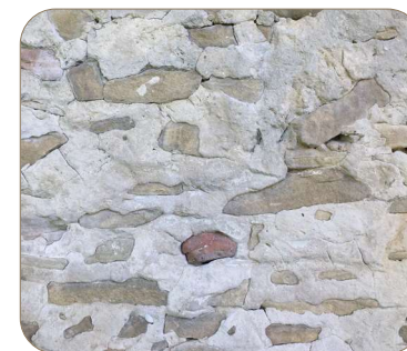
⑩ Maçonnerie pierre enduit chaux
