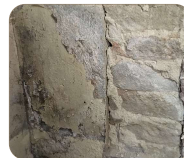
⑮ Embrasure, pierre de taille et maçonnerie
