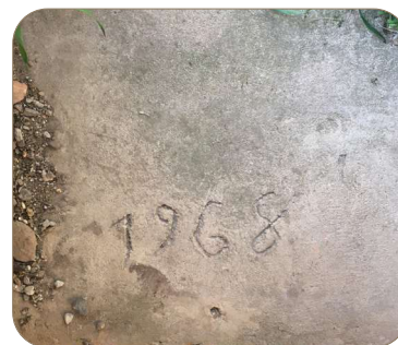
⑨ Reprise au ciment du cadre de fenêtre, date
