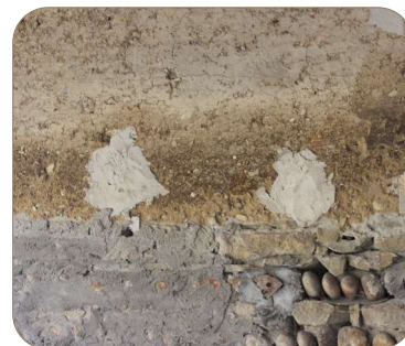
⑨ Trompe l'oeil sur enduit chaux
