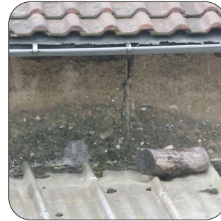
Fuites de toiture - Ravine - Infiltrations d'eau
