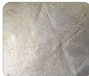
⑭ Palier, dalle pierre
