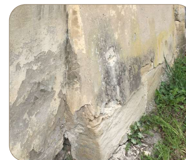
⑤ Soubassement pierre de taille, enduit chaux
