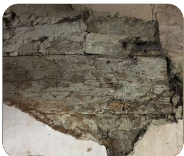
⑥ Ancien linteau bois dans le mur en pierre
