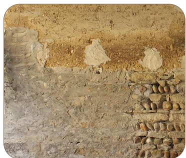
⑥ Reprises ciment sur pisé et soubassement
