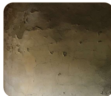
④ Enduit terre
