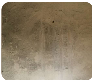
⑧ Enduit terre, traces de main
