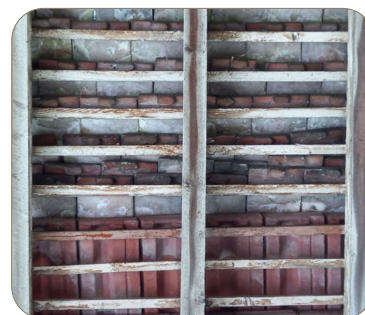
⑭ Chevrons et liteaux, tuiles anciennes et neuves
