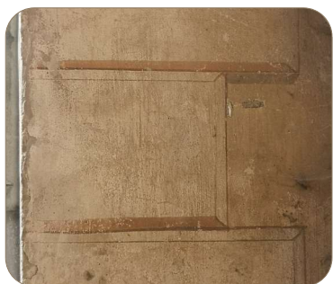
② Trompe l'oeil sur l'enduit chaux
