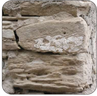
Gel/dégel + stagnation d'eau interface pisé-pierre.
