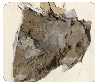
⑭ Peinture, plâtre et enduit terre sur maçonnerie pierre
