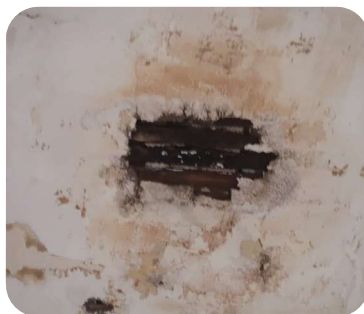
③ Perçement du plafond, zone humide
