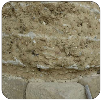
Gel/dégel + stagnation d'eau interface pisé-pierre.
