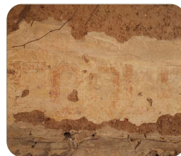
⑨ Trompe l'oeil sur enduit chaux
