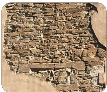
① Maçonnerie pierre et enduit chaux
