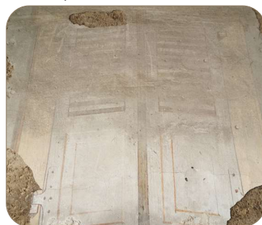
⑧ Trompe l'oeil sur enduit chaux
