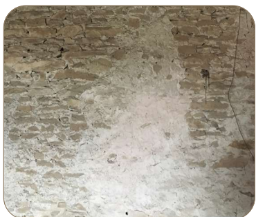
⑪ Maçonnerie pierre enduit chaux
