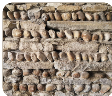
③ Maçonnerie pierre et galets en arrête de poisson
