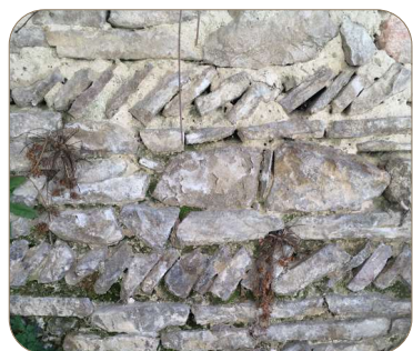
② Maçonnerie pierres en arrêtes de poisson
