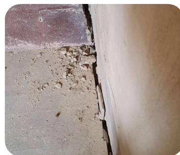
⑨ Plancher décollé du mur
