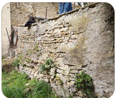
① Maçonnerie pierre et végétation sur le puits
