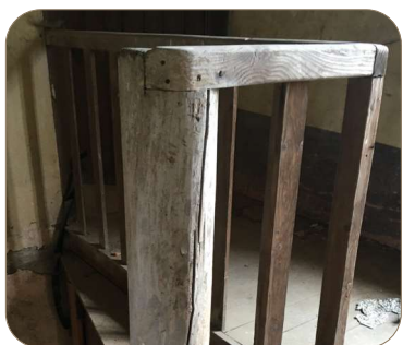
① Rampe d'escalier bois, assemblage
